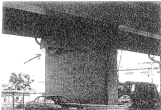
第17図 最初の破壊は、右側校舎の1階部分の柱の座屈から始まった。
